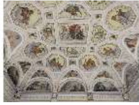
LaRes.II, Göttersaal, Gewölbemalereien, R.16, DI005310, BSV
